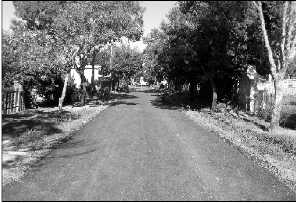
MEJORADO ASFÁLTICO. La obra se ha ejecutado en las dos primeras cuerdas de calle Rocamora, entre Perón e Itatí, y se extenderá hasta 1° de Mayo.
