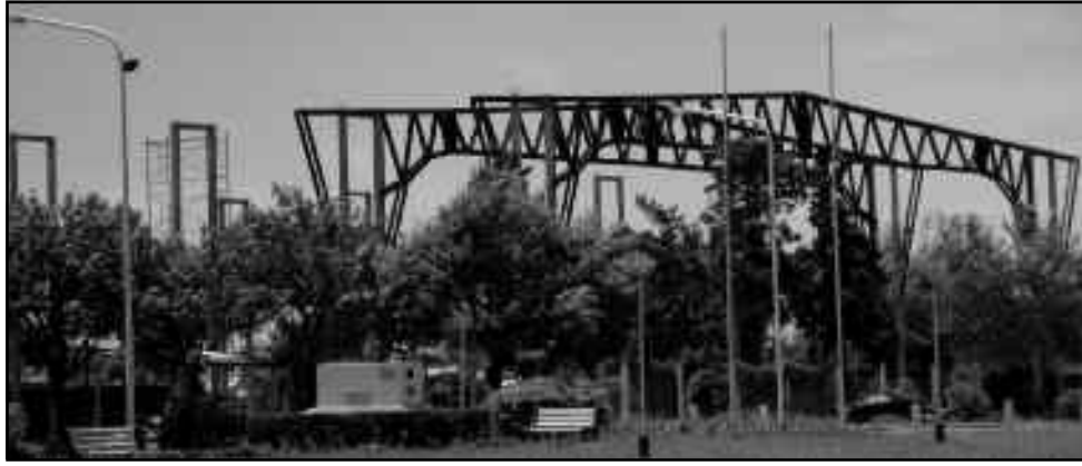
MONTAJE. Las estructuras metálicas sostendrán el techo del gimnasio cubierto en el polideportivo.
